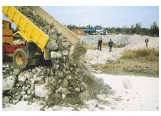
2 Dieses Beschütten eines Trenn- und Filtervliesstoffes dokumentiert die Wichtigkeit einer beanspruchungsgerechten Festlegung der Geotextilrobustheitsklasse
